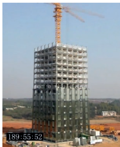
Рис. 1. Скоростное сборное строительство отеля T 30 в провинции Хунань (КНР)
