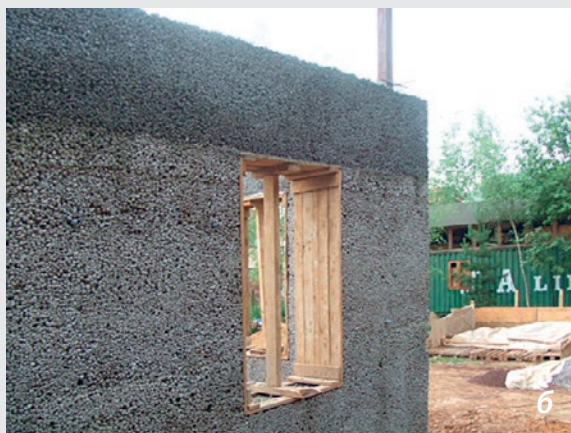
Материал «КАПСИМЭТ»: а — образец плотностью 620 кг/м 3 ; б — в качестве объемного заполнителя наружной стены строящегося дома с каркасом из трубобетона (пос. Немчиновка Московской области, 2007 год)
